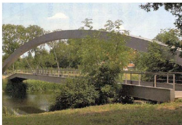
Speciaal voor de vestingroute ontworpen brug.
