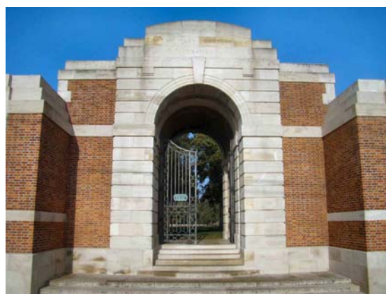
Het poortgebouw dat toegang geeft tot de begraafplaats.
