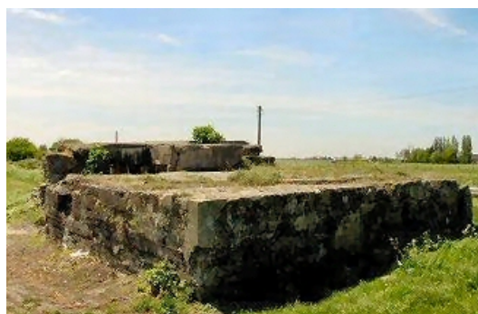
De Duitse bunker bij het einde van de site.
